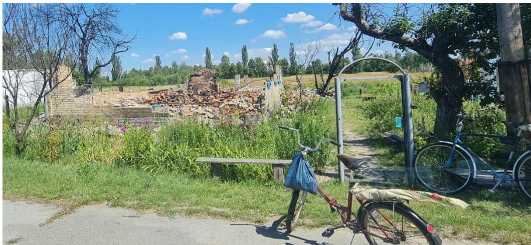
Будинок повністю зруйнований.
