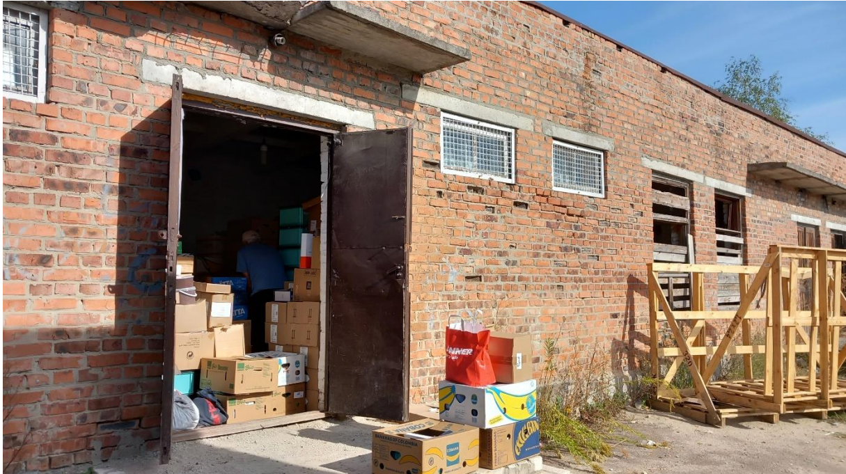
Opslag van hulpgoederen
